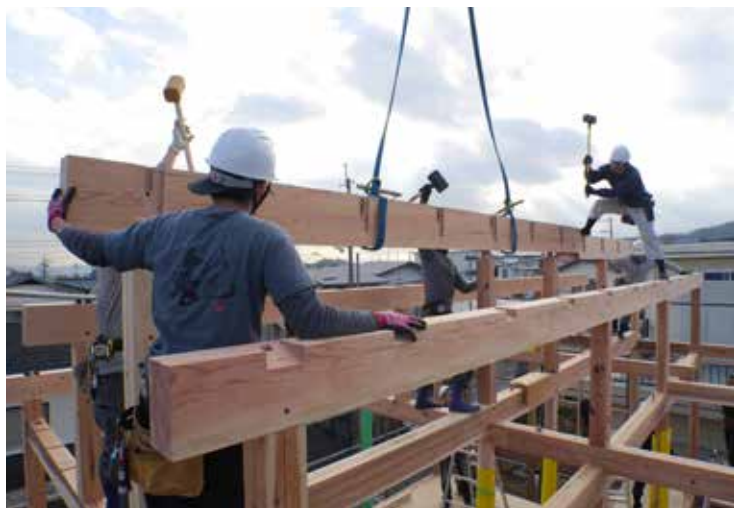
写真5 手刻みでつくる家の棟上げの風景。棟上げは手刻み大工において極めて重要な工程であり大きなイベントとなる。
