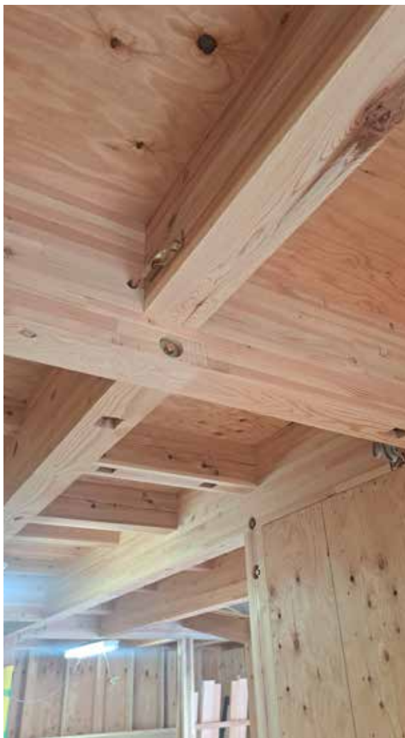
写真 12 いま多くの住宅では「集成材を使って、それを金物で接合する」という方法が一般的。この方法では節の位置や木目による強度はほとんど問題にならない。
