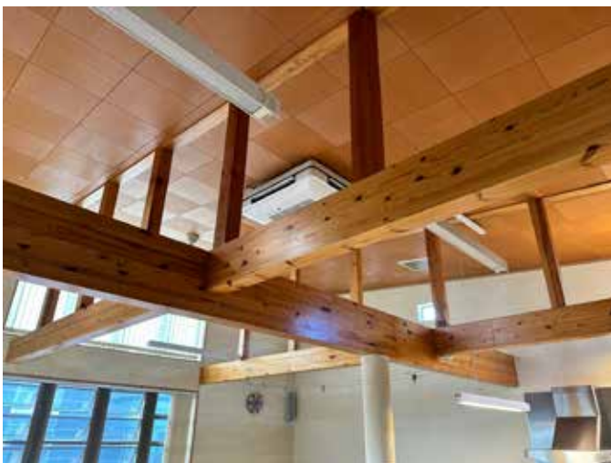
写真 22 集成材の梁を見せる内観の例。天井の意匠なども含め、日本らしい住まいとは印象が大きく異なる。
