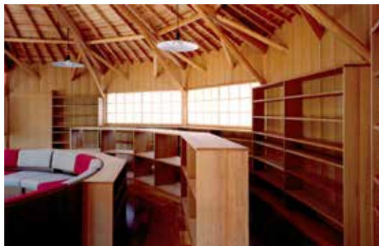
写真 24 手刻みの技術がこうした美しい木組みを実現させる。
