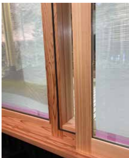
写真 16 気密性の向上に工夫した木製建具。 気密測定の結果も極めて良好だったもの。
