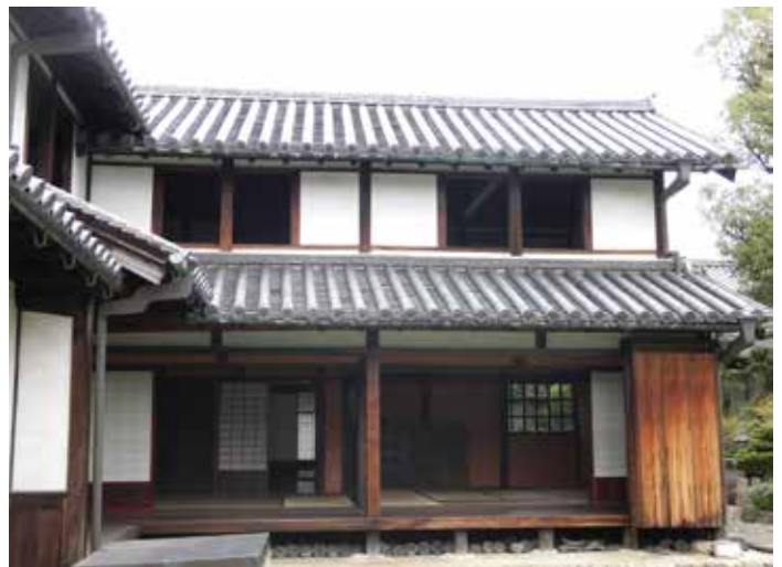
写真15 外真壁の伝統的な住宅。
