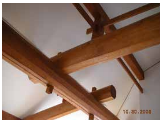
写真 25 構造材を美しく見せる、手刻みの技術による改修。
