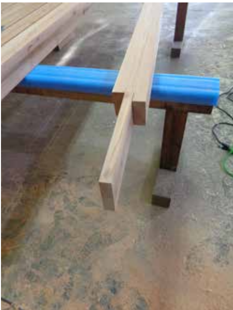
写真 12 地震や台風の力で接合部が抜けるなどのリスクを小さくする手刻みの工夫。
