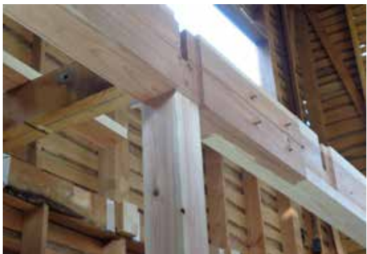
写真 25 構造材を美しく見せる、手刻みの技術による改修。
